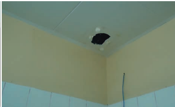
BURACO NO TETO DA UTI DO HOSPITAL DE PATOS
